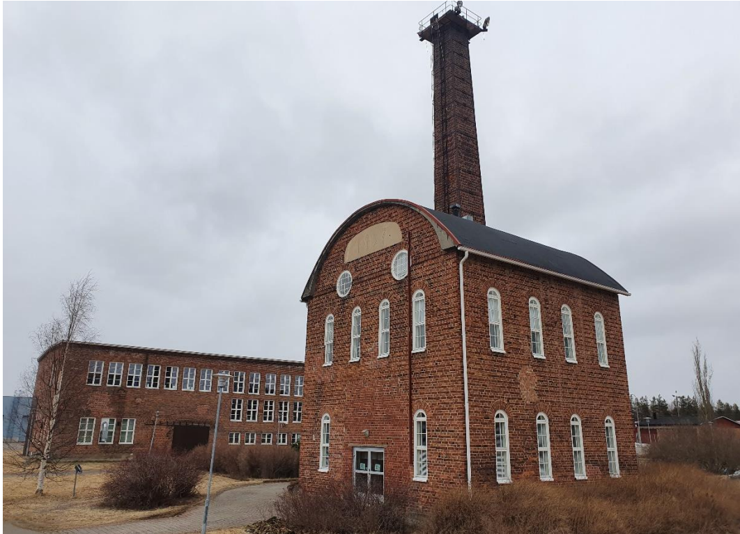
Kuva 8. Höyryvoimalan rakennus. Rakennus sijaitsee suunnittelualueen läheisyydessä.
