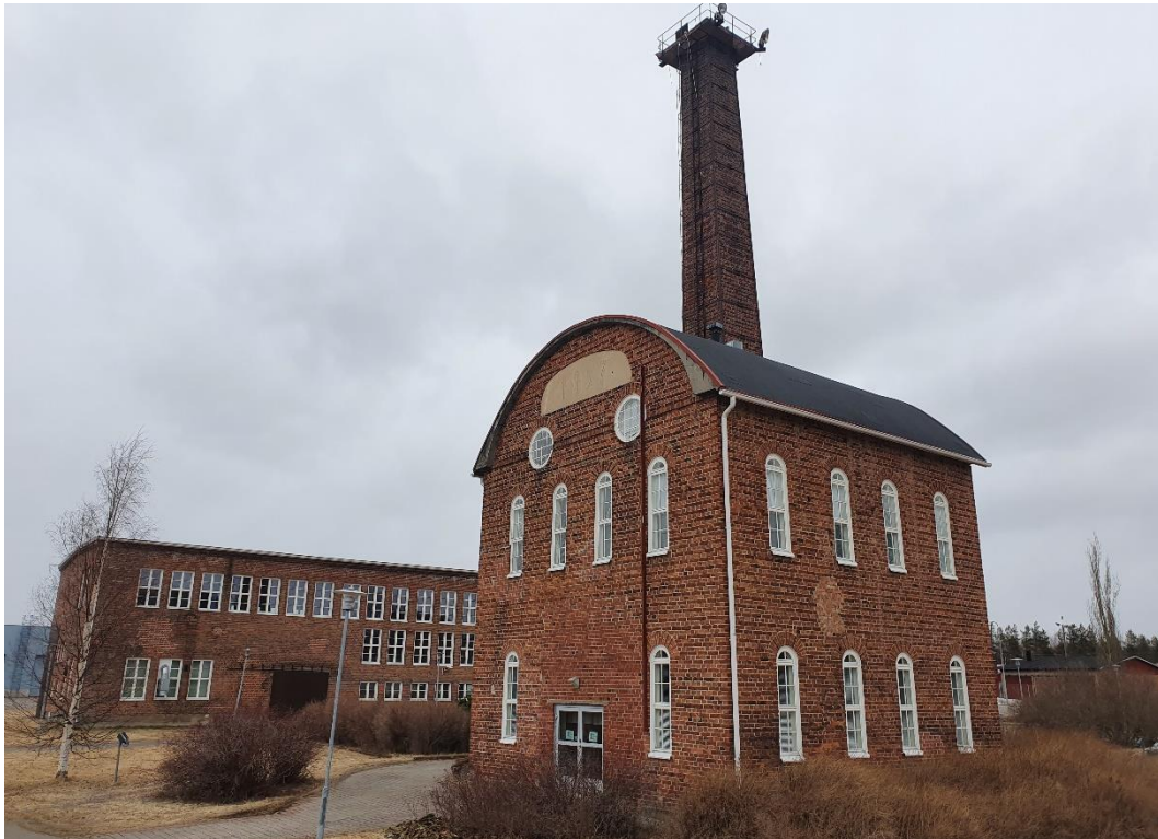
Kuva 8. Höyryvoimalan rakennus. Rakennus sijaitsee suunnittelualan läheisyydessä.
